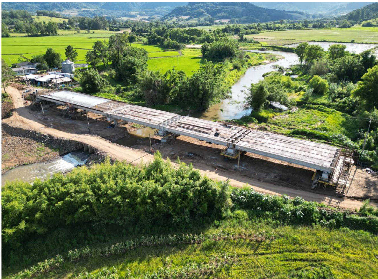
A NOVA PONTE SOBRE O ARROIO GUARDA MOR, NO TRECHO ENTRE IVORÁ E O ACESSO A FAXINAL DO SOTURNO, NA ERS-348, É UMA DAS OBRAS MAIS ADIANTADAS
