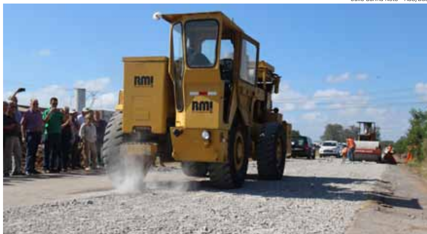
O equipamento, trazido dos Estados Unidos, utiliza tecnologia ressonante para fragmentar blocos de concreto e reaproveitá-los na reconstrução do trecho
